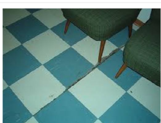
Pavimento in vinil-amianto.
