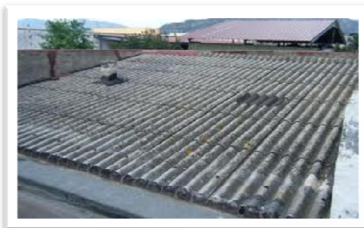
Tetto in cementoamianto.
